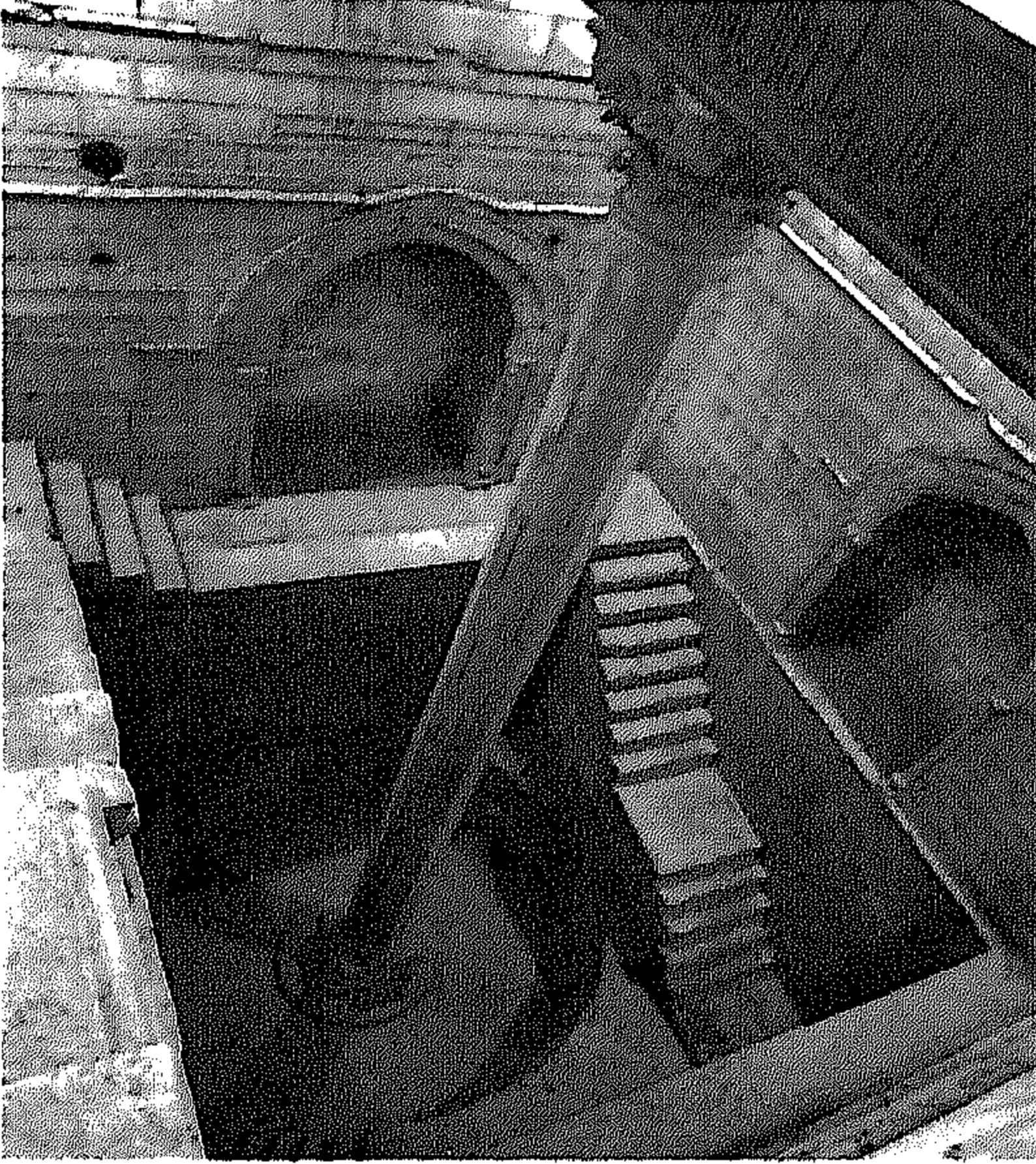
مقياس النيل من الداخل - عمود المقياس المركزي والسلم - القاهرة.
